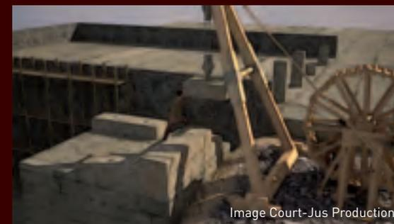
Grâce à des « trous de louves », les gros blocs étaient mis en place au moyen de machines de levage.
