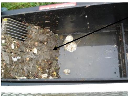
Cas d'une entrée de station colmatée (dégrilleur bouché)
