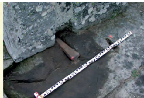
■ Agrafe assemblant des blocs de grand appareil. ©J.-L. Paillet
