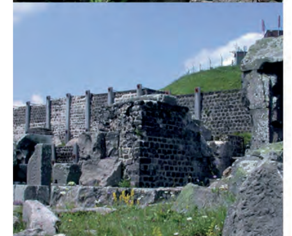
■ Les blocs de pouzzolane serts à la chaux, le matériau du gros œuvre ©J.-L. Paillet
