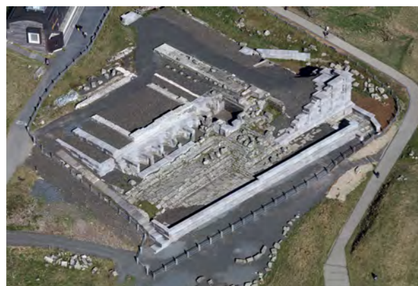
■ Le sanctuaire de Mercure en 2015, après la première phase de travaux ©4 vents
