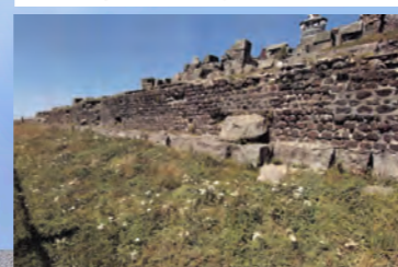
■ Le mur sud avant restauration ©Beaulaton
