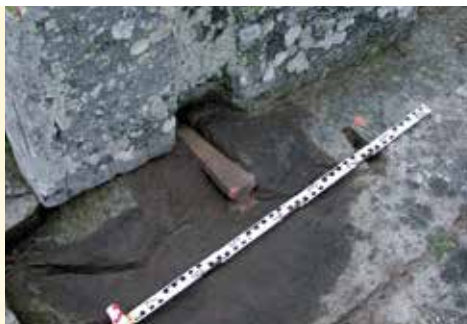
■ Agrafe assemblant des blocs de grand appareil. ©J.-L. Paillet
