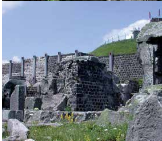
■ Les blocs de pouzzolane serts à la chaux, le matériau du gros œuvre ©J.-L. Paillet
